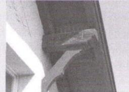
Hrotový systém je vhodný na ochranu rovných méně členitých ploch, jako jsou například okna a rímsy. Životnost hrotového systému se pohybuje okolo 10 let. Systém zabraňuje dosedání ptactva na chráněné plochy nebo stavbě hnizd v rozích a koutech. Síťový systém je vhodný pro plochy v blízkosti míst využívaných ptactvem pro příjem potravy.
